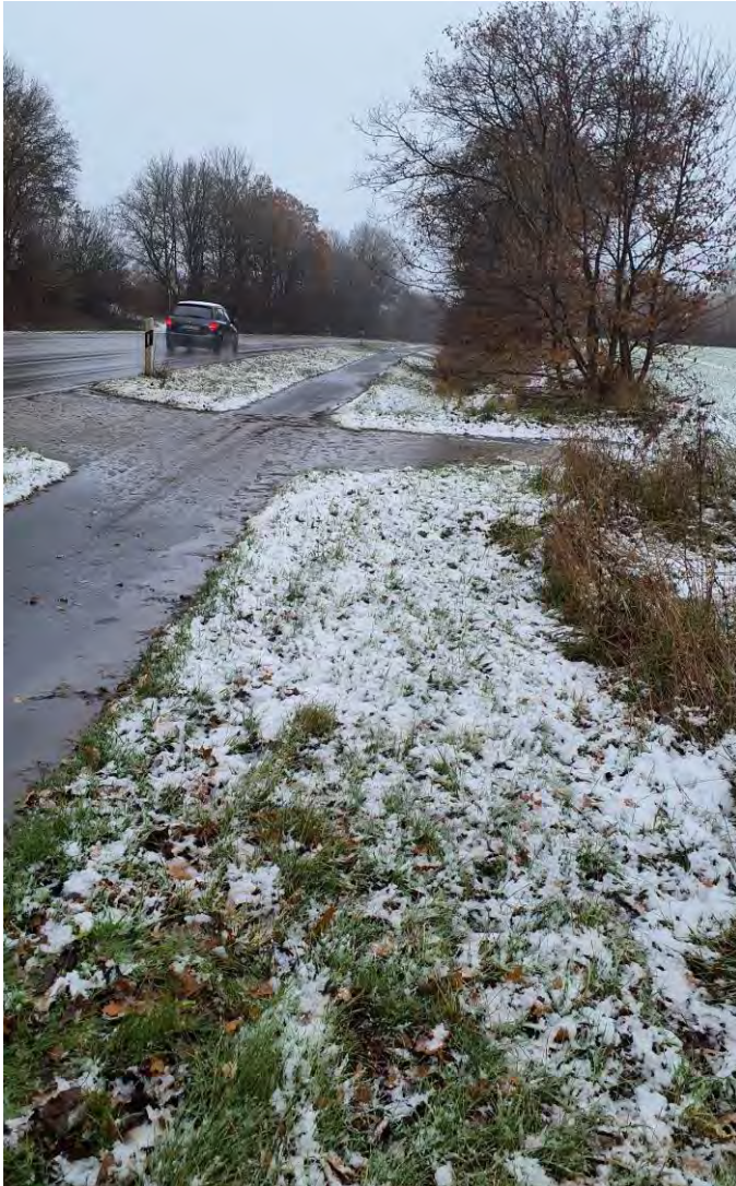
Abbildung 8: Entwässerungsgraben (FGy), Radweg (SVs), Bankette (SVi) und Bundesstraße (SVs)
