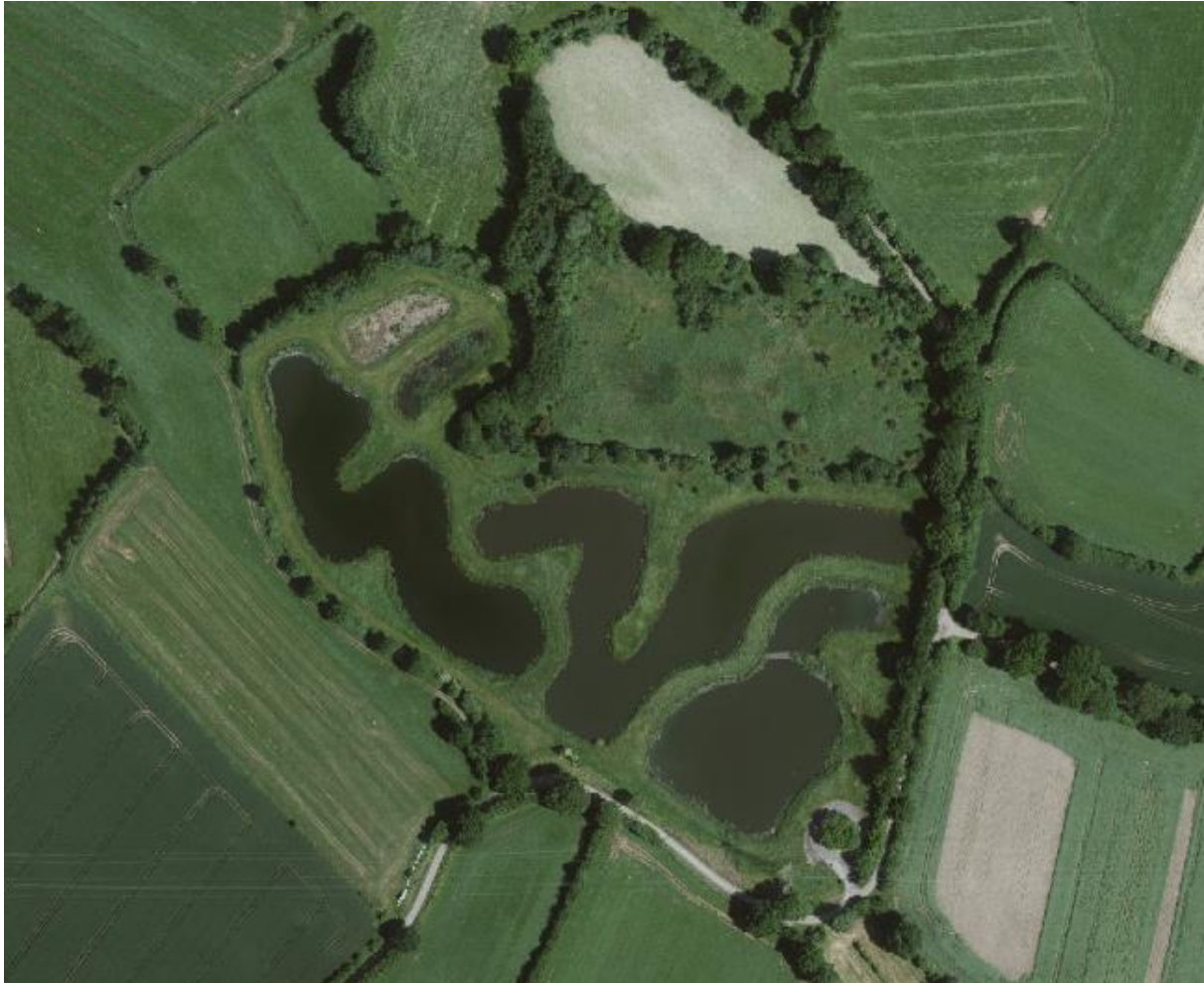
Bild 1-1: Luftbild der Kläranlage [Digitaler Atlas Nord]
