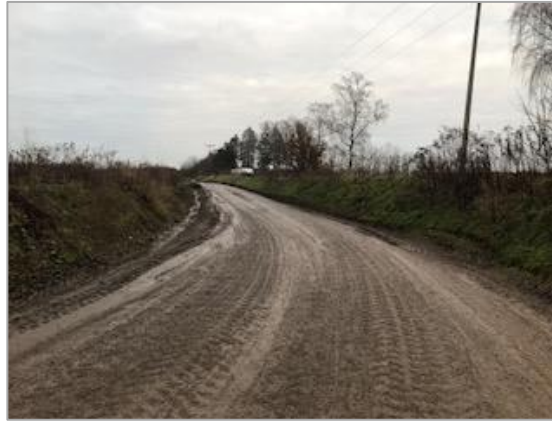
Kiesabfuhrtrasse parallel Harksheider Straße/Mittelspannungsleitung
